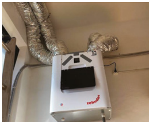
Figura 12. Sistema di distribuzione in aula (a sinistra) e VMC installata nel bagno (a destra). Una macchina dedicata ad ogni aula. Scuola primaria in Abruzzo
