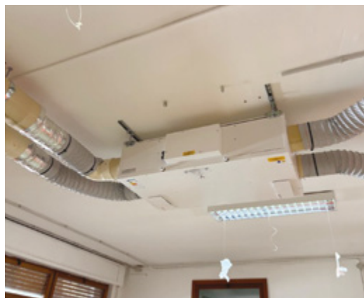
Figura 13. Sistema di distribuzione in aula (a sinistra) e VMC installata nel corridoio (a destra). Una macchina dedicata ad ogni aula. Scuola secondaria di secondo grado di Bari
