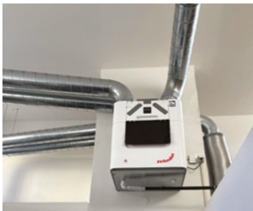
Figura 10. Sistema di distribuzione in aula (a sinistra) e VMC installata nel bagno (a destra). Una macchina dedicata ad ogni aula. Scuola primaria di Bolzano
