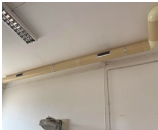
Figura 13. Sistema di distribuzione in aula (a sinistra) e VMC installata nel corridoio (a destra). Una macchina dedicata ad ogni aula. Scuola secondaria di secondo grado di Bari
