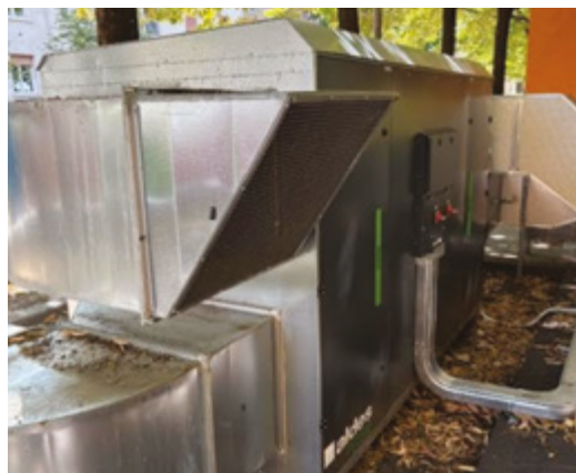
Figura 11. Sistema di distribuzione in aula (a sinistra) e VMC installata all'esterno (a destra). La macchina è dedicata a quattro aule e una mensa. Scuola primaria di Bolzano
