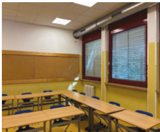
Figura 11. Sistema di distribuzione in aula (a sinistra) e VMC installata all'esterno (a destra). La macchina è dedicata a quattro aule e una mensa. Scuola primaria di Bolzano
