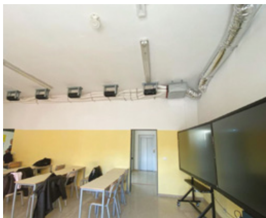
Figura 12. Sistema di distribuzione in aula (a sinistra) e VMC installata nel bagno (a destra). Una macchina dedicata ad ogni aula. Scuola primaria in Abruzzo
